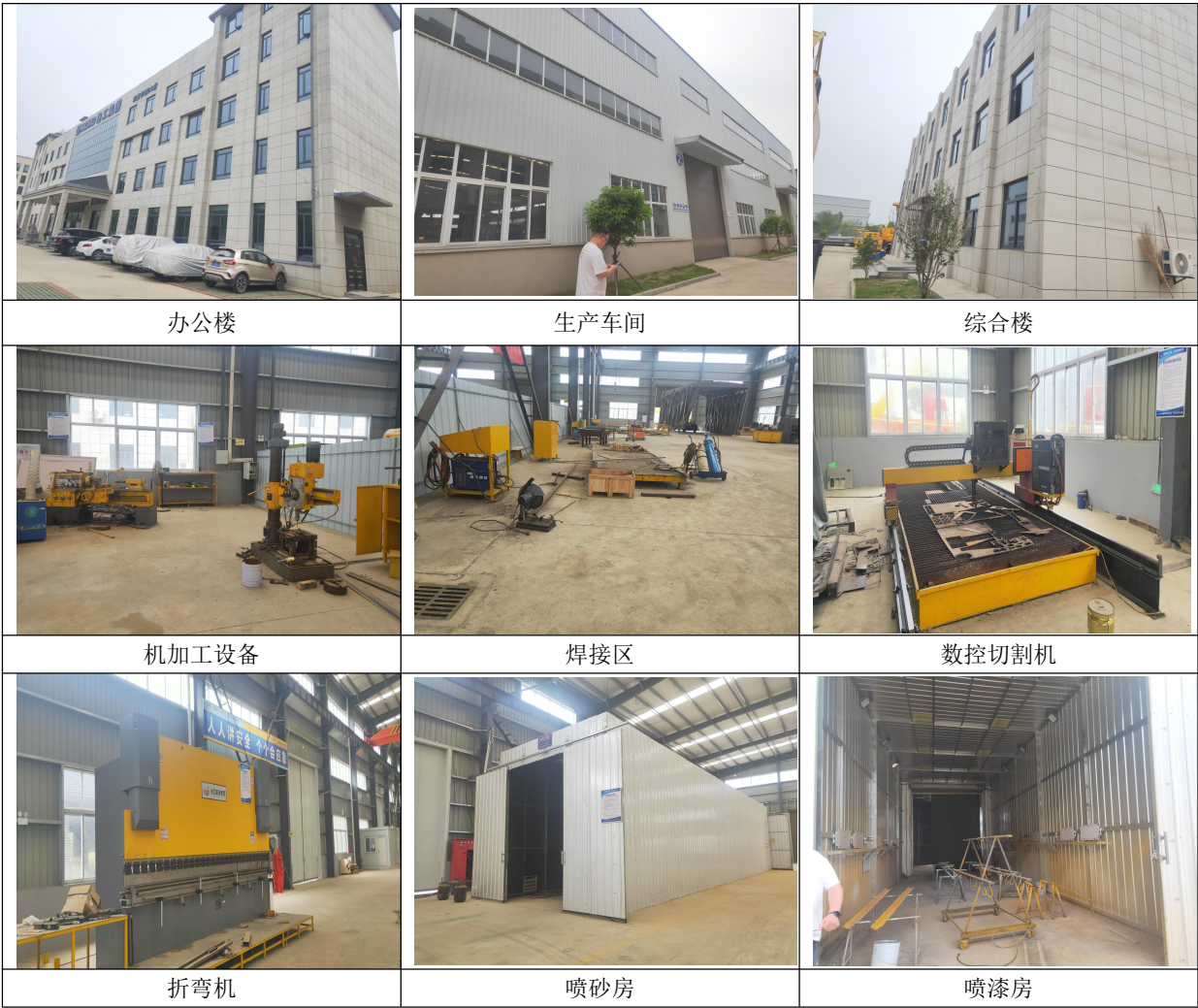
图 2-1 项目现场情况图片
