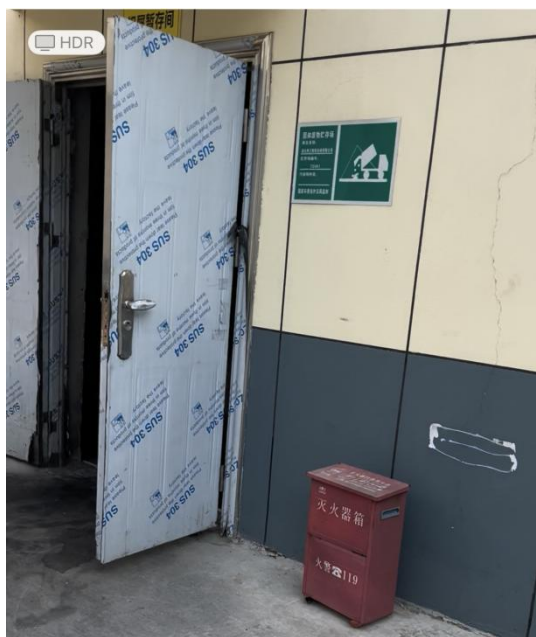
一般工业固体废物暂存间
