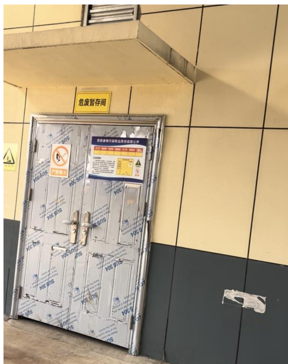
危险废物暂存间
