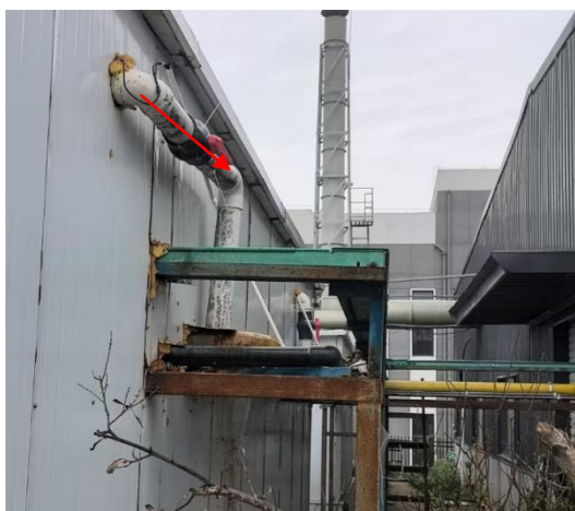
污水处理站废气收集管道
