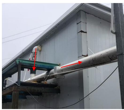
污水处理站废气收集管道
