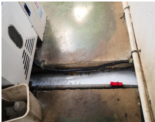
车间排水沟（喷水织布废水）
