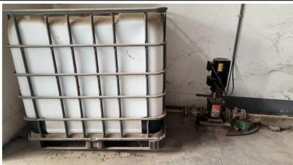
脱硝设施（炉内脱硝，氨水喷淋）
