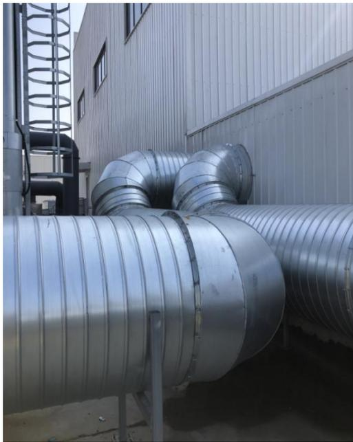
2#车间有机废气集气管道
