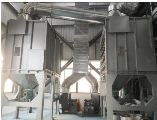
滤筒除尘器（1#车间投料、输送工序）
