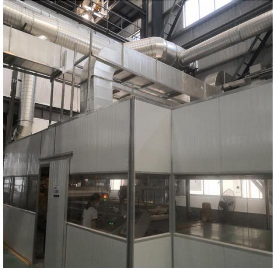
真空压料布料封闭区及集气管道（1#车间）
