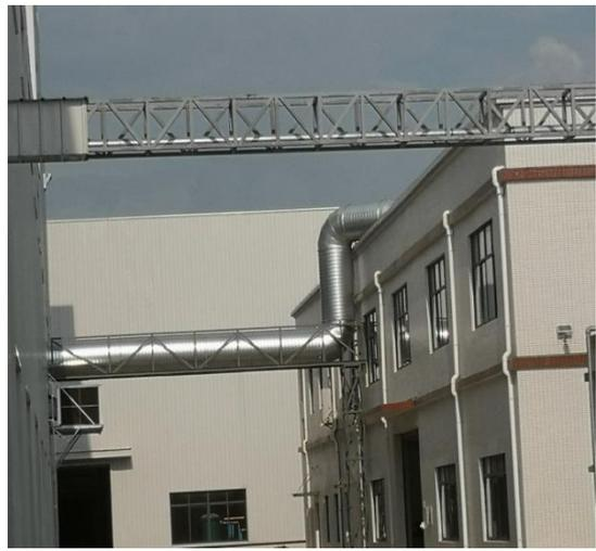
1#车间有机废气集气管道
