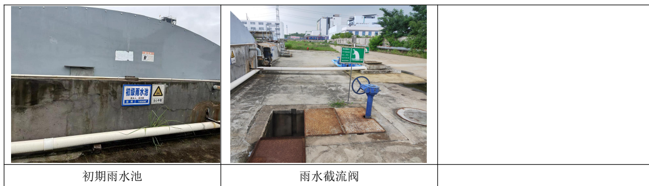
图 4.1-3 厂区初期雨水收集系统图
