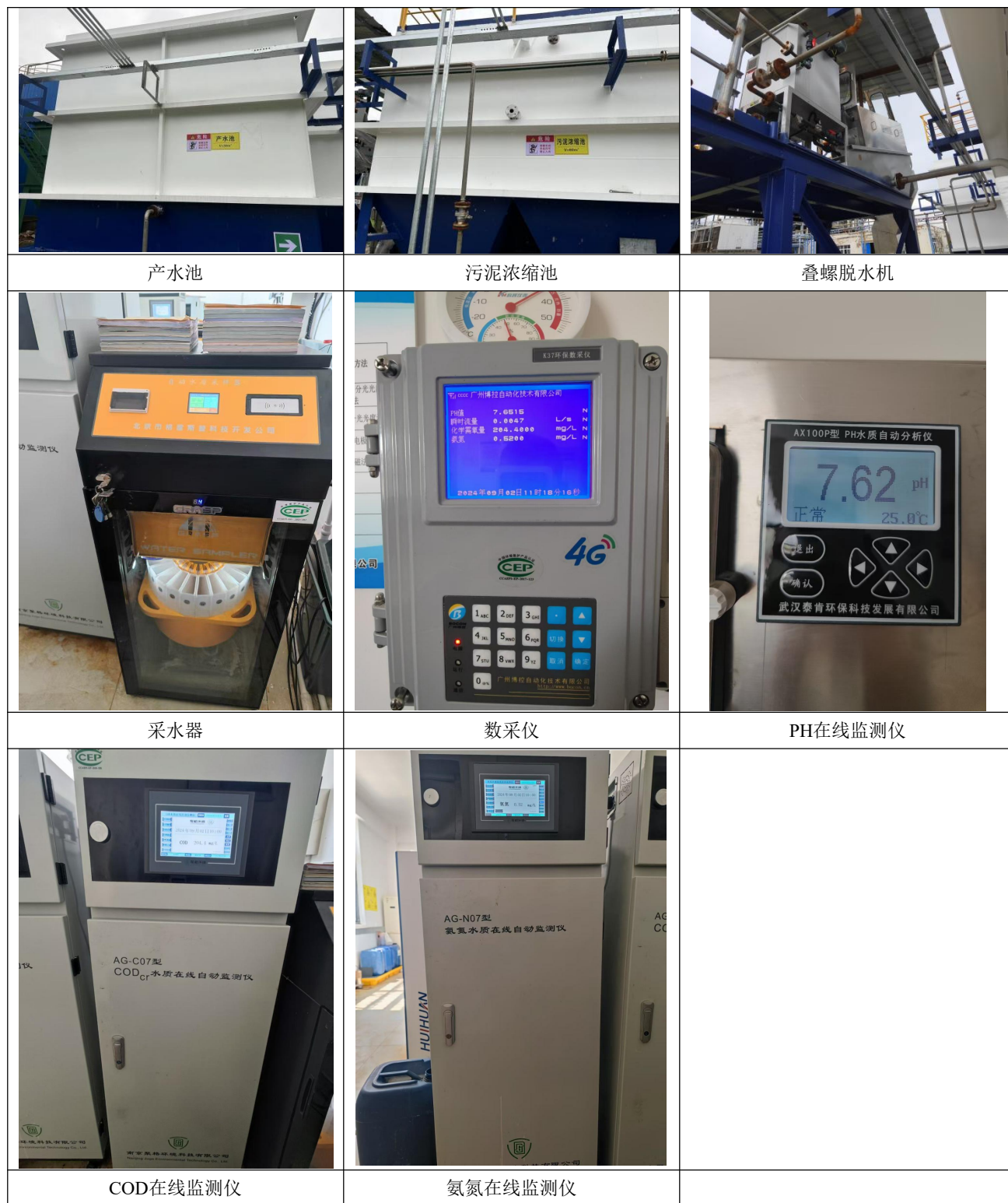
图 4.1-2 项目废水收集处理措施图
